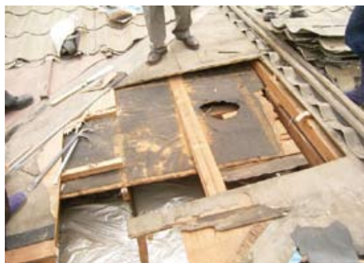
■ 下地劣化状況調査
