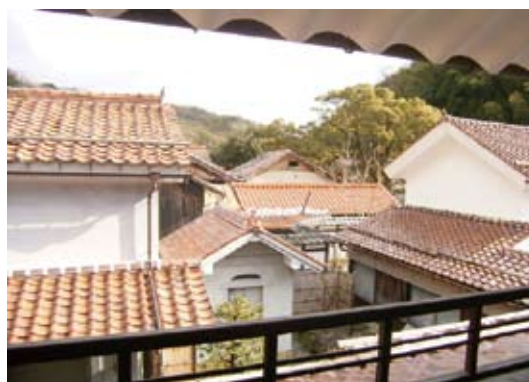
■ 石州瓦の調査（島根県大田市）
